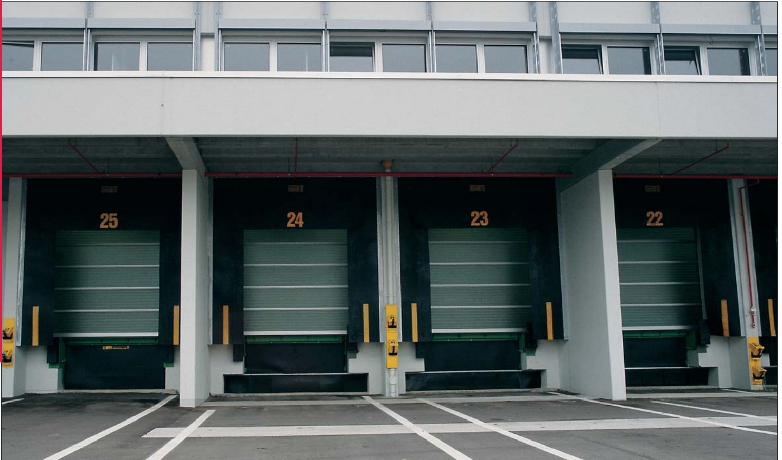
Verladeanlage mit elektrohydraulischen Anpassrampen. Unterfahrbar mit Ladebordwänden.
