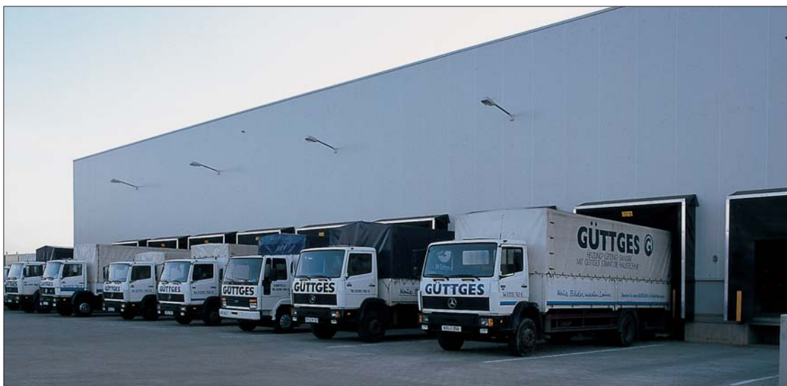
Verladewetterschutz mit Pufferzonen-Vorbau, der seitlich mit PVC verkleidet ist.
