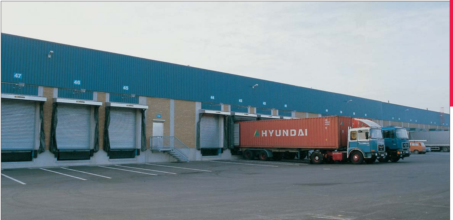
Elektrohydraulische Rampen und pneumatische Verladewetterschutze.
