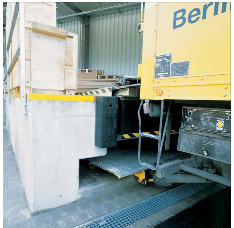
Die elektrohydraulische Anpassrampe ist mit einer Ladebordwand unterfahrbar.
