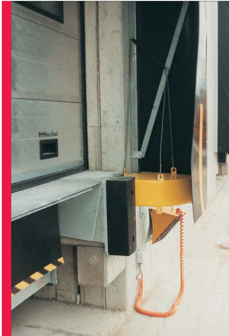
Zusatzabdichtung mit Extra-Stahlhalterungselement für einseitige Befestigung. ▼
