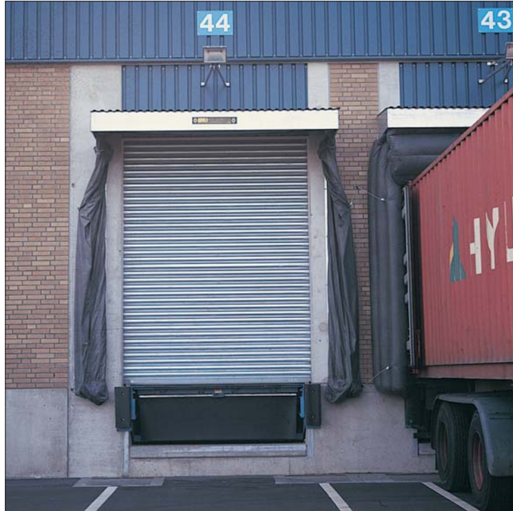
Pneumatischer Verladewetterschutz ohne seitliche Verkleidung.
