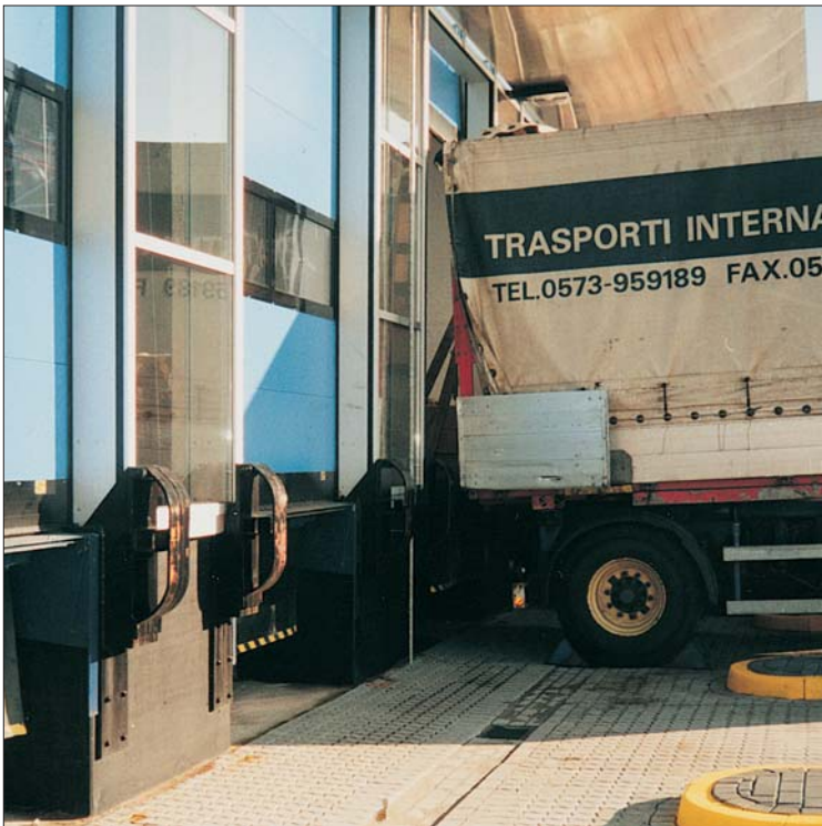
Einsatz: Glasfassade wird mittels Dual-Federstahlpuffer geschützt.
