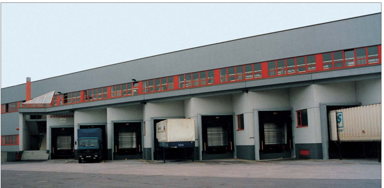
Elektrohydraulische Anpassrampen mit Vorschub und Verladewetterschutz für bauseitigen Betonvorbau in QUALITYline .
