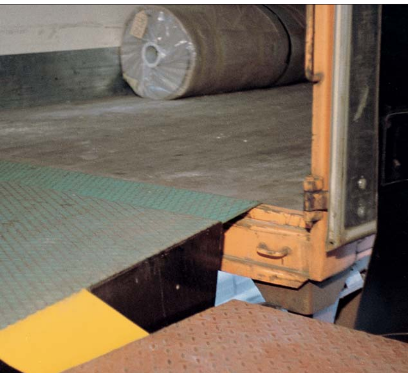
Mittels der Teleskoplippe ist die Auflagefläche beliebig ansteuerbar.
