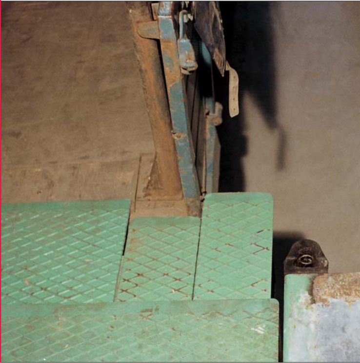
Federbelastete, seitliche Einschubsegmente zur Breitenanpassung.
