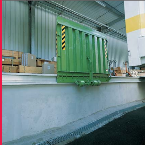
ARNOLD federmechanische Verladebrücke aus Stahl, Oberfläche lackiert, verschiebbar ▼
